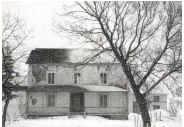
Maison de Rivière-Ouelle endommagée suite à la secousse de 1925
