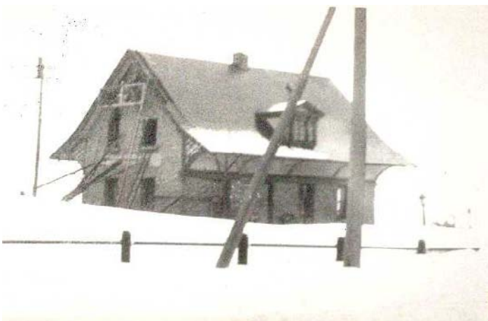
Les murs de la gare furent délogées de la fondation jusqu'au plafond par la première secousse
