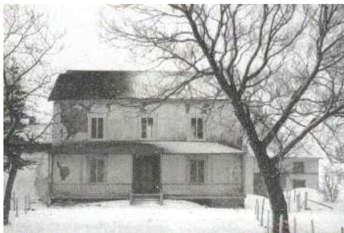
Figure 1 Ancienne résidence de pierre des Letellier démolie à cause des dommages
