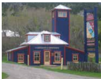
Ancien poste des pompes de Saint-André transformé en boutique.
