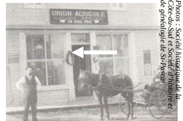
Vitrine à 4 grands carreaux
